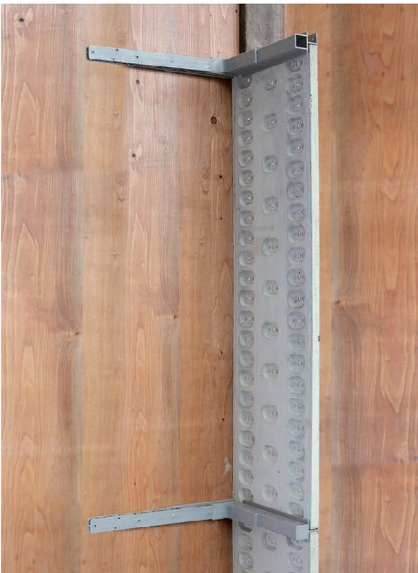
Régler en hauteur tout élément ZEMBORD supplémentaire jusqu'à la hauteur de coffrage désirée, puis le fixer, au niveau de la zone de jointure, avec des équerres ZEMBORD.\*
