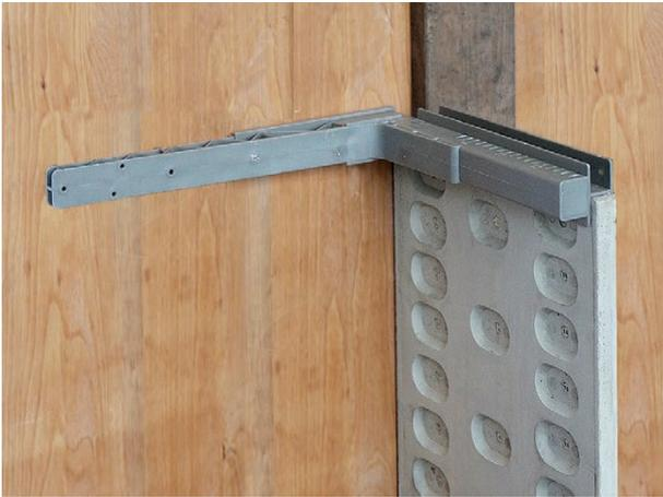
Fixer l'élément ZEMBORD sur le panneau-support via des équerres ZEMBORD (vue de l'intérieur).
