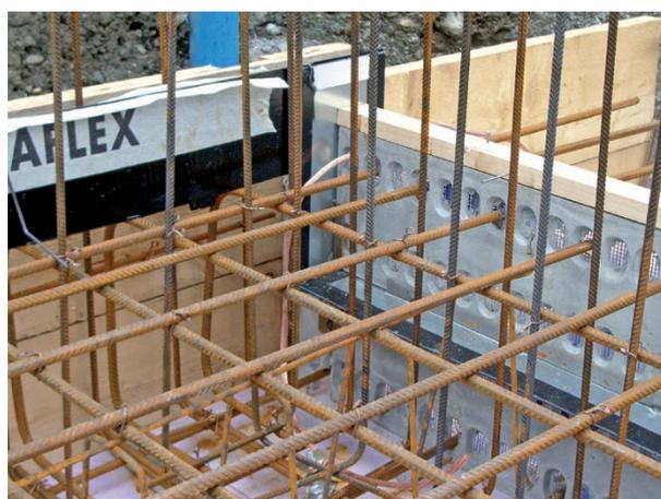
Béton imperméable à l'eau
