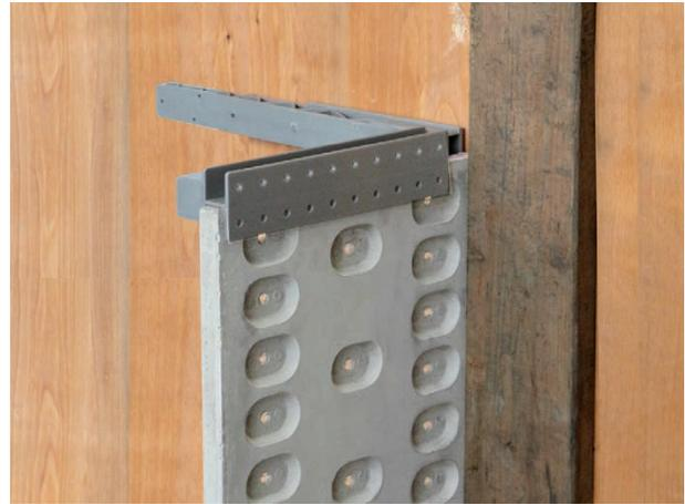
Fixer l'élément ZEMBORD sur le panneau-support via des équerres ZEMBORD (vue de l'extérieur).
