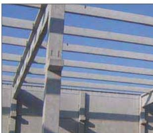
Raccordement d'éléments préfabriqués en béton
