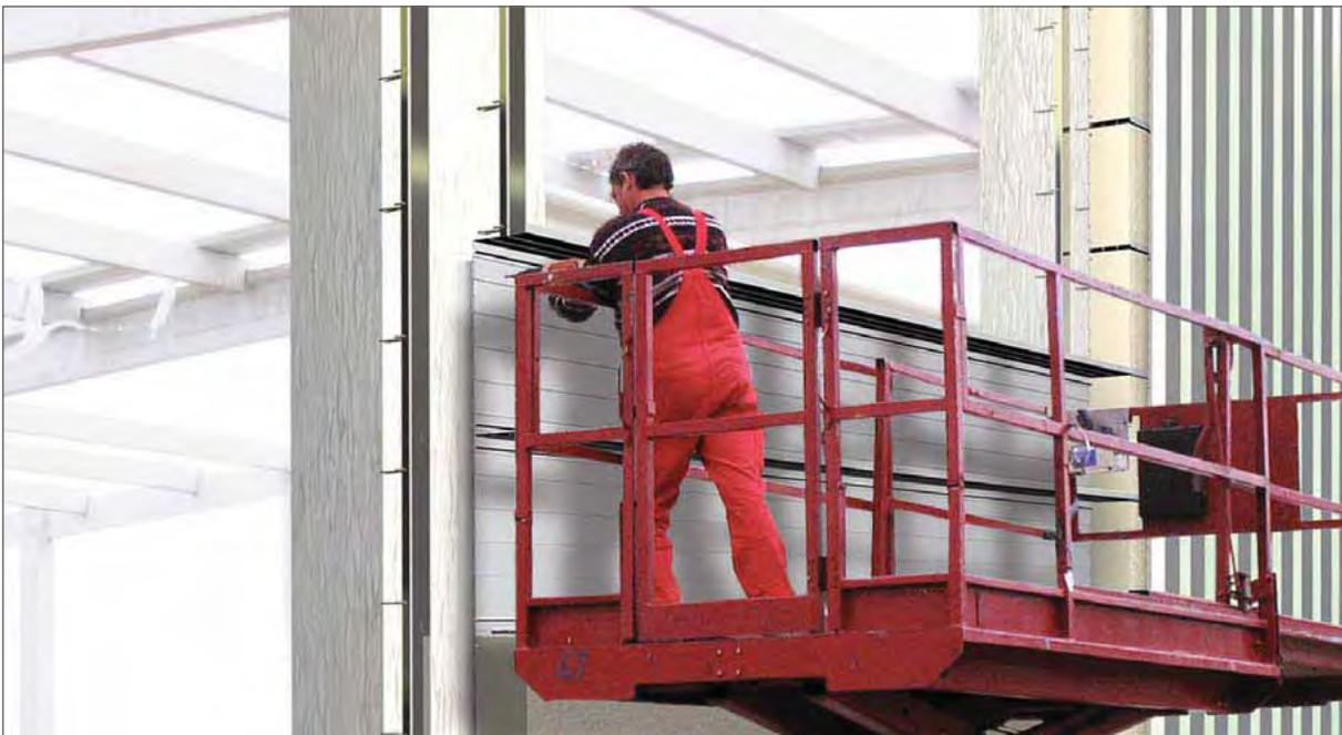
Installation d'un bardage isolé multicouche de façade
