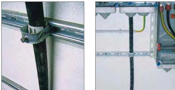
Les profils de montage JORDAHL® crantés et / ou perforés peuvent être utilisés pour la fixation de câbles à l'aide de colliers.
