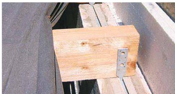
Fixation de chevrons sur poutres avec des plats cloués et des rails de raccordement
