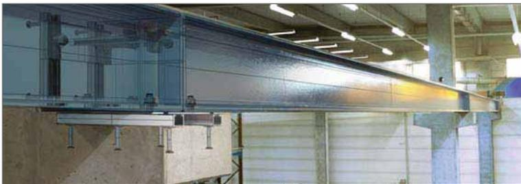
Fixation de voies de ponts-roulants sur des éléments préfabriqués en béton
