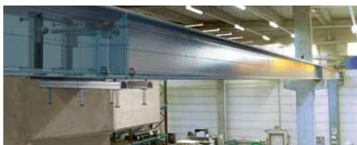
Fixation de voies de ponts-roulants sur des éléments préfabriqués en béton
