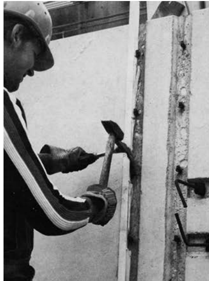
Nach dem Ausschalen die Trägerleiste entfernen
