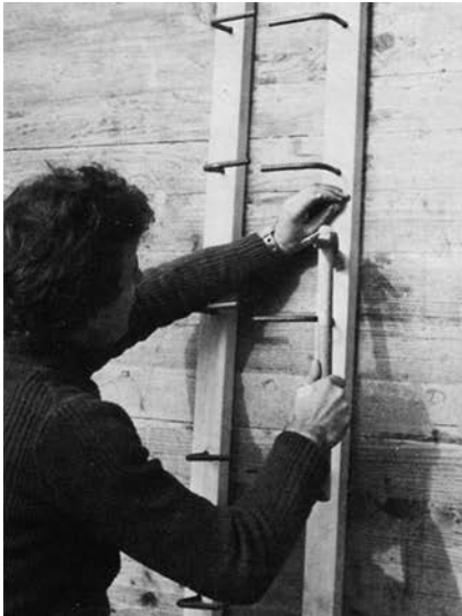
Annageln von der Einbauseite auf die Schalung
